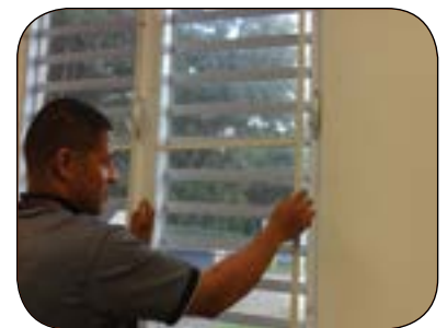
Installez ou réparez les moustiquaires sur les fenêtres et portes.
